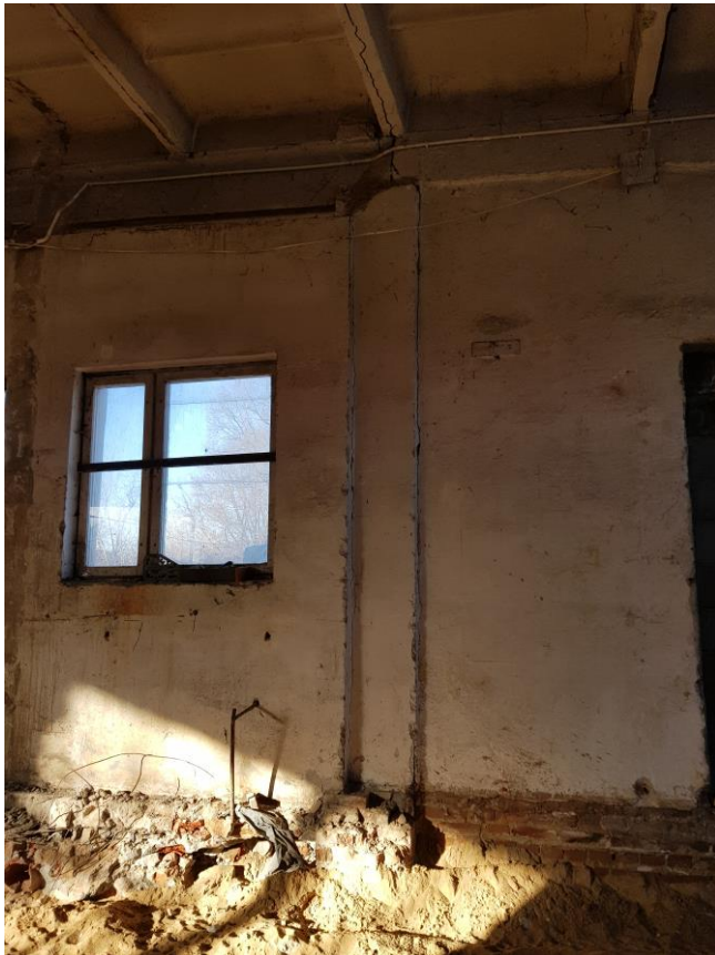
2. Spękania belek stropodachu
